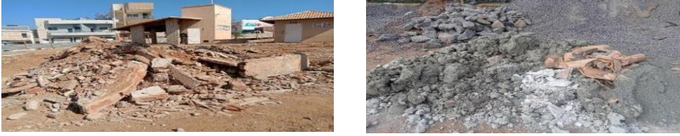
Figura 1: Resíduos pertencentes às classes A, B e C encontrados no bairro Centro.
