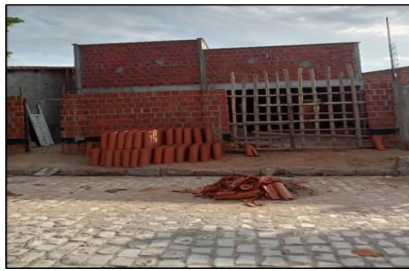
Figura 4: Canteiro de obra de nova construção, bairro Leandro Bezerra.
