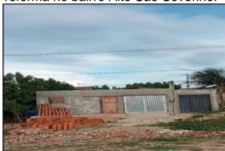
Figura 6: Canteiro de obra de reforma no bairro Alto São Severino.
