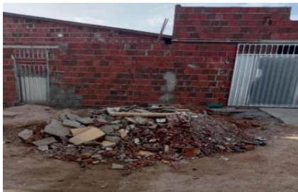
Figura 3: Canteiro de obra de reforma no bairro Leandro Bezerra.
