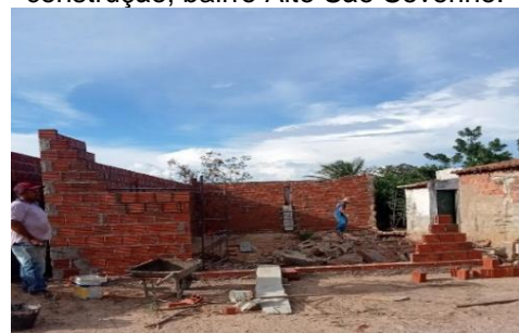
Figura 7: Canteiro de obra de nova construção, bairro Alto São Severino.
