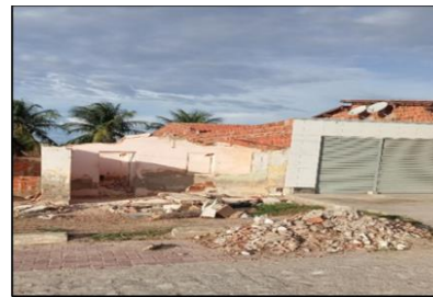
Figura 5: Canteiro de obra de demolição, no bairro Leandro Bezerra.
